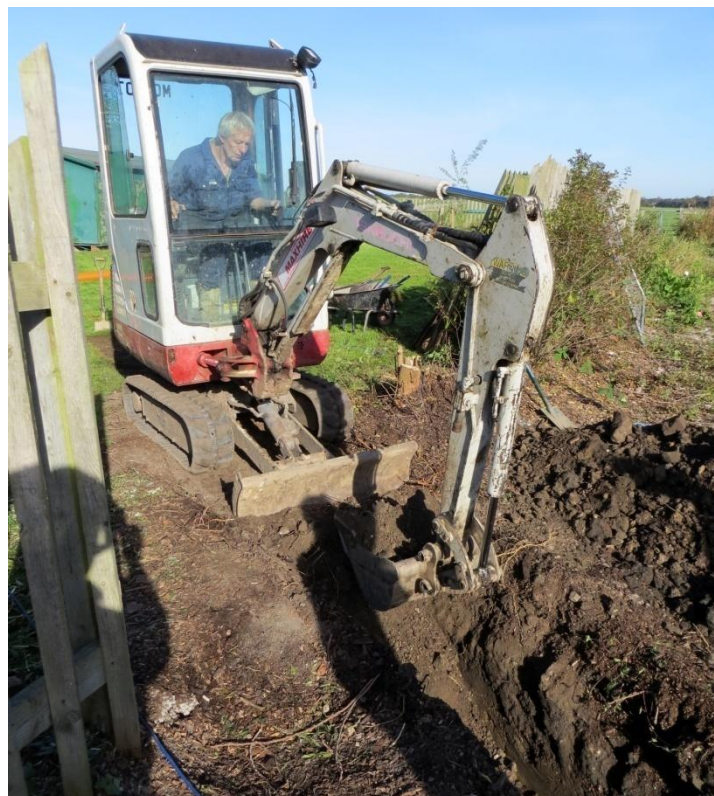
Dave Nesbitt on the mini excavator
