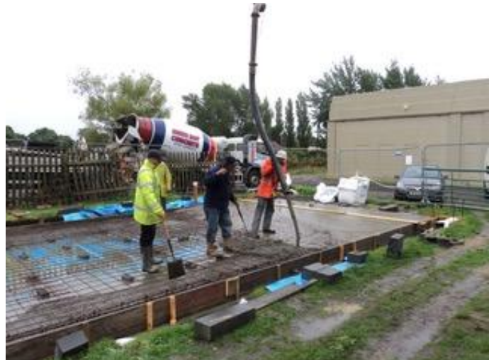
Pouring the floor-slab
